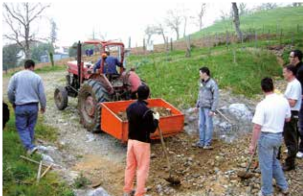
Remise en état d'un chemin rural lors de la 16ème Journée des Chemins, par les bénévoles d'un moto-club.
