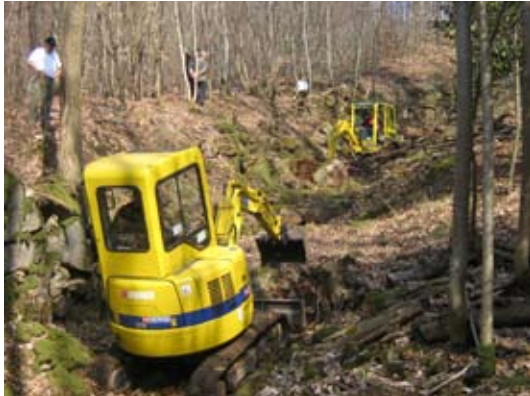
Grosse opération de remise en état d'un chemin rural à Schirmeck (68)
